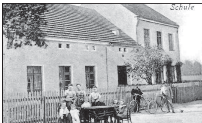
Szkoła przed przebudową
