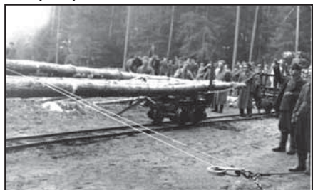
Transport drewna przy pomocy kolejki
