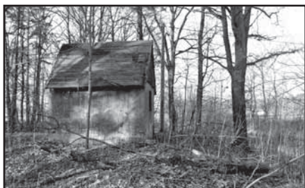
Przepompownia w Fazańcu
