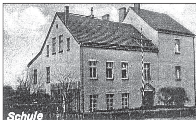
Szkoła po przebudowie
