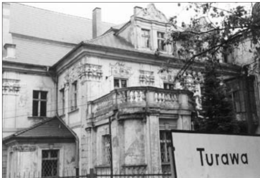
Pałac – stan elewacji od strony południowej.
