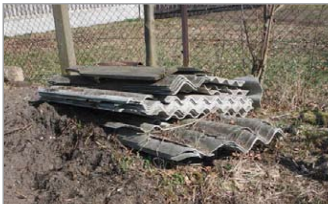
Pryzma azbestu przygotowana do odbioru
